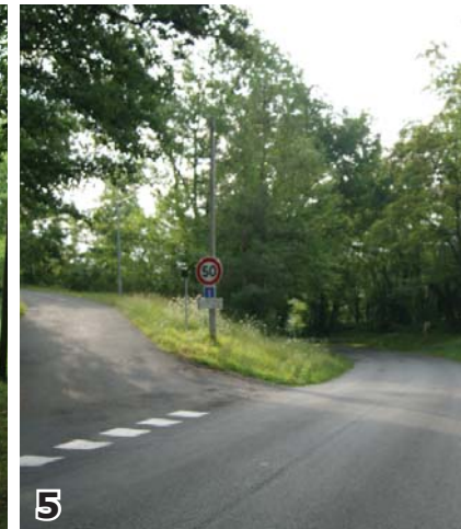
5 Arrivée sur le carrefour : aucun problème lorsque l'on souhaite continuer tout droit (route prioritaire). Néanmoins, s'engager à tourner à gauche apparaît comme relativement dangereux, au vu du manque de visibilité par rapport aux véhicules pouvant déboucher d'en face.
