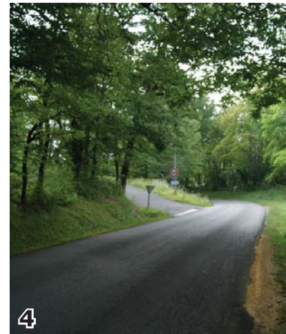
4 Dorénavant, le carrefour est à une vingtaine de mètres. Toujours aucune visibilité au loin (à gauche, du fait de la végétation imposante et d'un talus ; tout droit, à cause de la géométrie de la chaussée : en pente et dans un virage).
