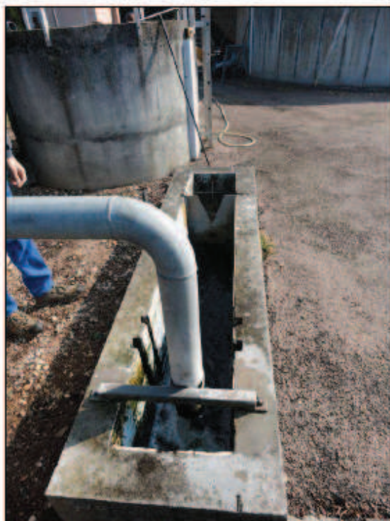
Vue du canal permettant la mesure de débit en sortie de STEP
