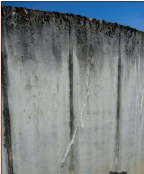
Vue des fissures sur l'ouvrage du bassin d'aération
