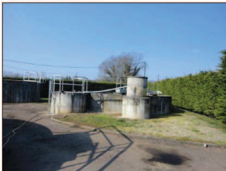
Vue du puits de dégazage, du clarificateur et de l'ouvrage de recirculation des boues
