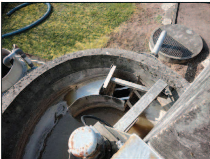
Vue du dégraisseur raclée
