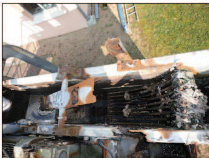
Vue de l'arrivée de la canalisation de relevage et de l'état du dégrilleur automatique
