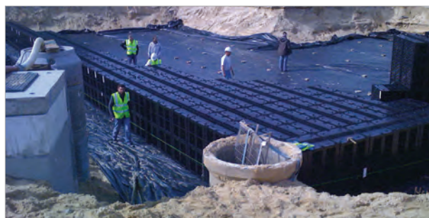
Commune de Lège-Cap Ferret – volume 770 m3 Suppression d'un rejet d'eaux pluviales vers le milieu récepteur Maître d'Ouvrage : SIBA, réalisation 2011
