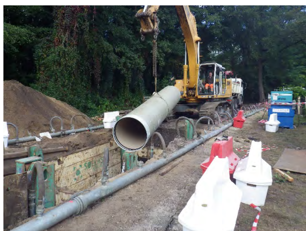
Pose des conduites en PRV
