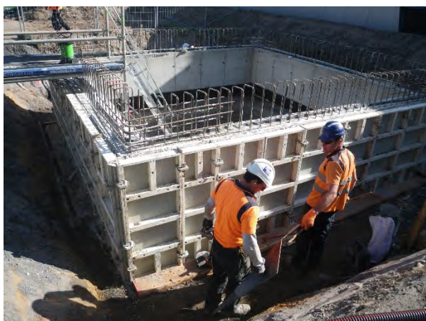
Poste de pompage Perrault – coulage de la trousse de havage
