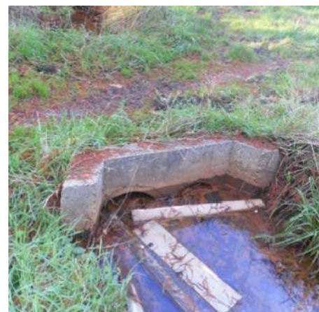
Photo n°3 : Buses obstruées sur le ruisseau Darricau au niveau du Clos des Alouettes, le 27/11/2013
