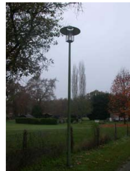
Luminaire dont l'éclairage est bien orienté vers le bas (Bourriot-Bergonce)
