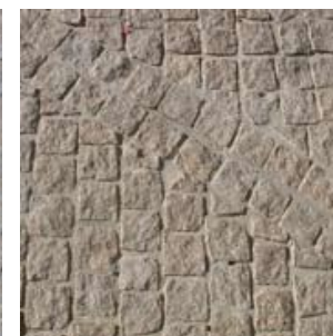
Pavage en granit beige éclaté en pose régulière
