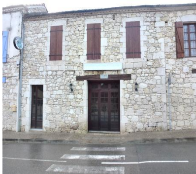
Photographie UrbaDoc : Utilisation de calcaire dans la construction traditionnelle locale.
