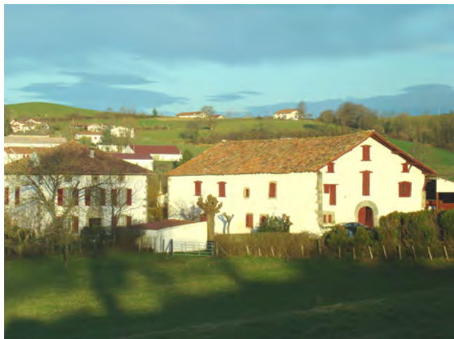
En partie « agglomérée » de grandes maisons typiques à l'architecture affirmée
